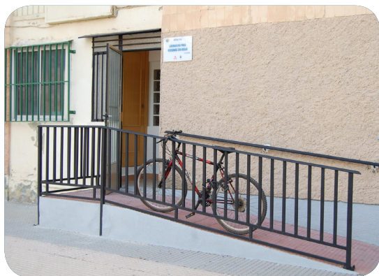
Fachada de la Lavandería Solidaria.
