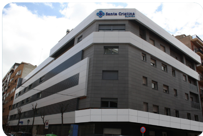
Fachada de la Clínica Santa Cristina.
